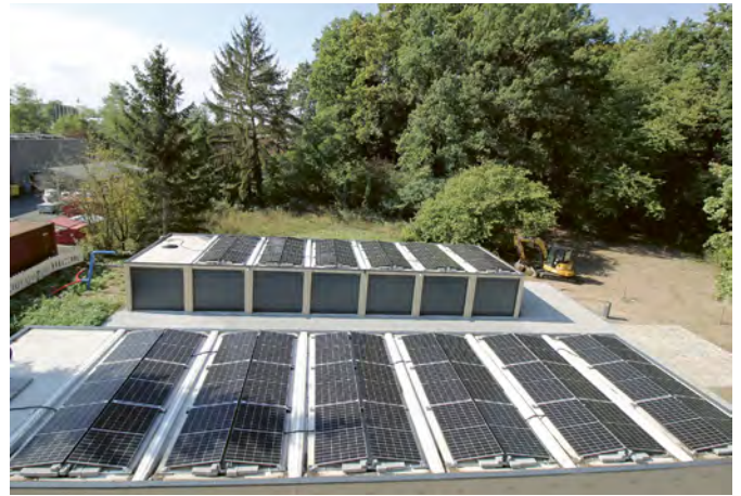
Die Luftwärmepumpe und Photovoltaikanlagen auf den Garagendächern am letzten Neubau Ronhofer Hauptstraße 269 in Fürth sorgen für eine klimafreundliche Wärmeversorgung.
