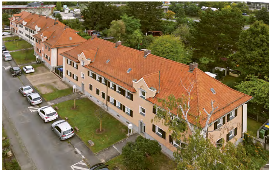
Widderstraße 33, 35 in neuer Farbe.
