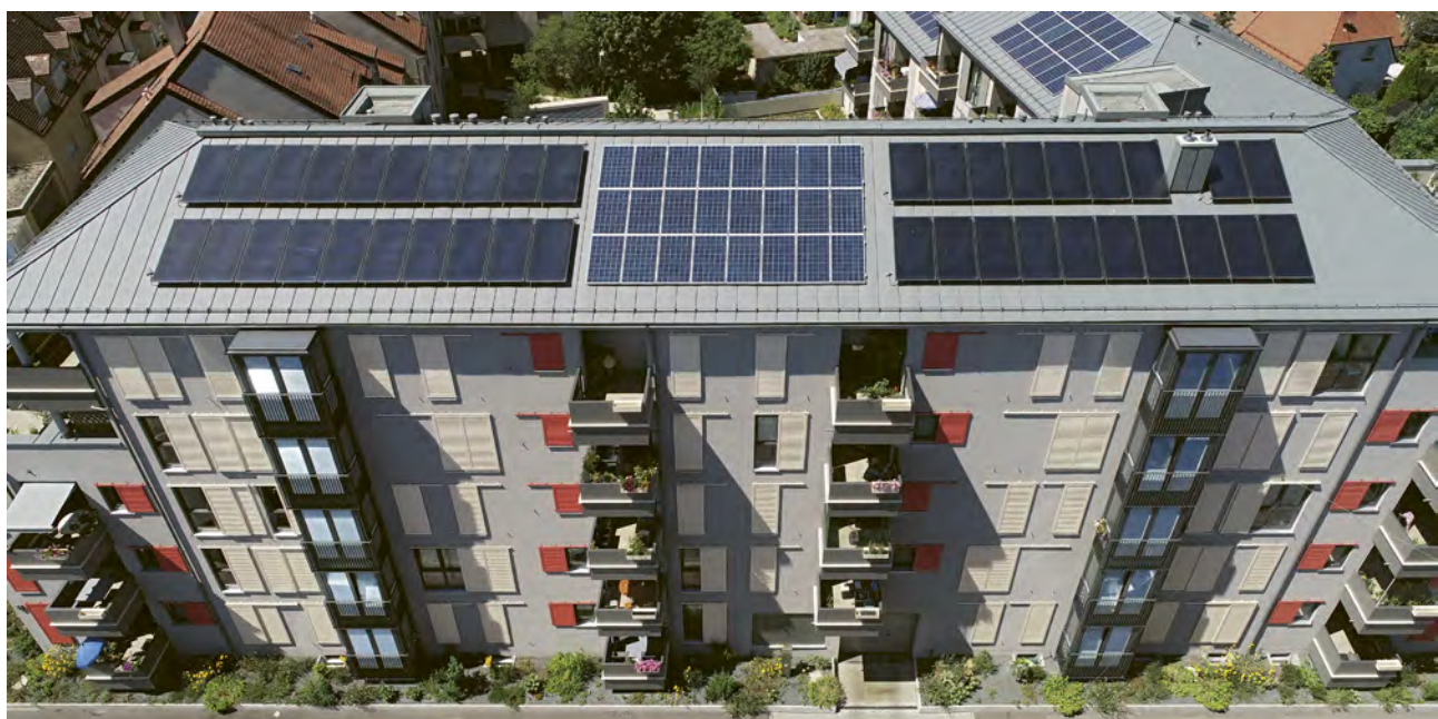
Dachfläche in der Wiesen-/Georgenstraße in Fürth mit Solarthermie und Photovoltaik.
